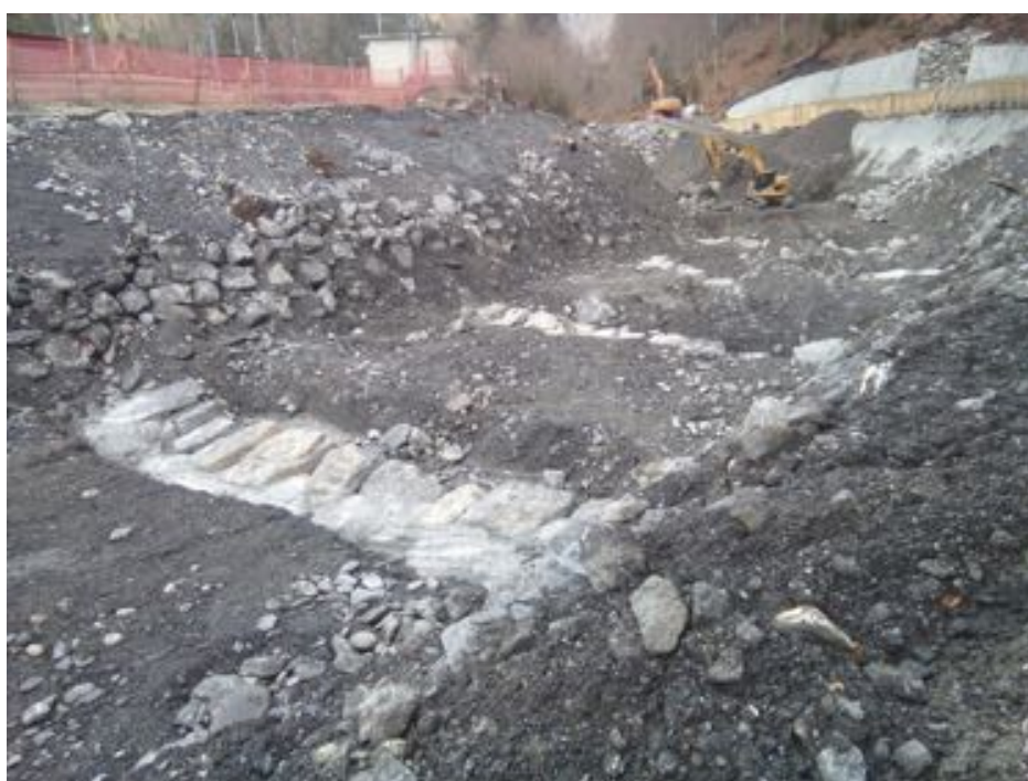
Abbildung 5 und 6 Impressionen vom Umbau des Sandweidli Wehrs (Julian Schäfer)
